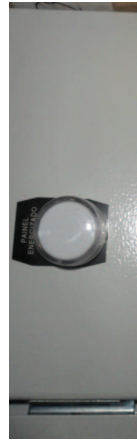
Fig. 15- Foto da luz indicadora "PAINEL ENERGIZADO".
