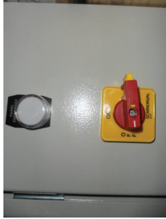
Fig. 14- Foto da chave geral na posição "off".
